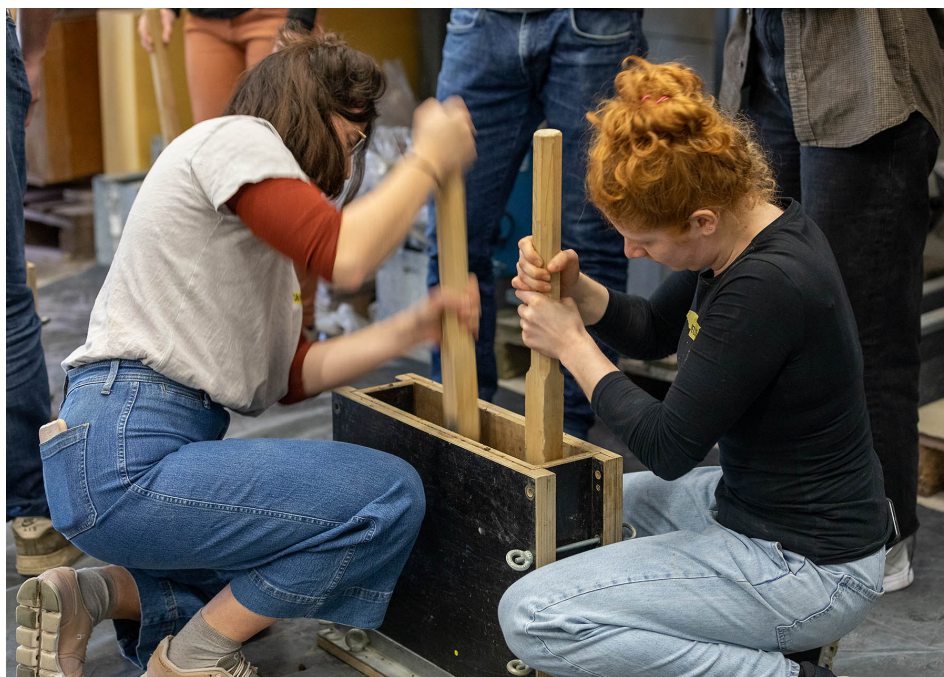
03 Stampflehm: Lehm schichtweise verdichten, Materialwerkstatt HSLU 2023
