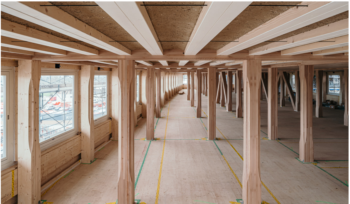
01 Hortus Basel, Innenansicht – Holz Lehm Decke
