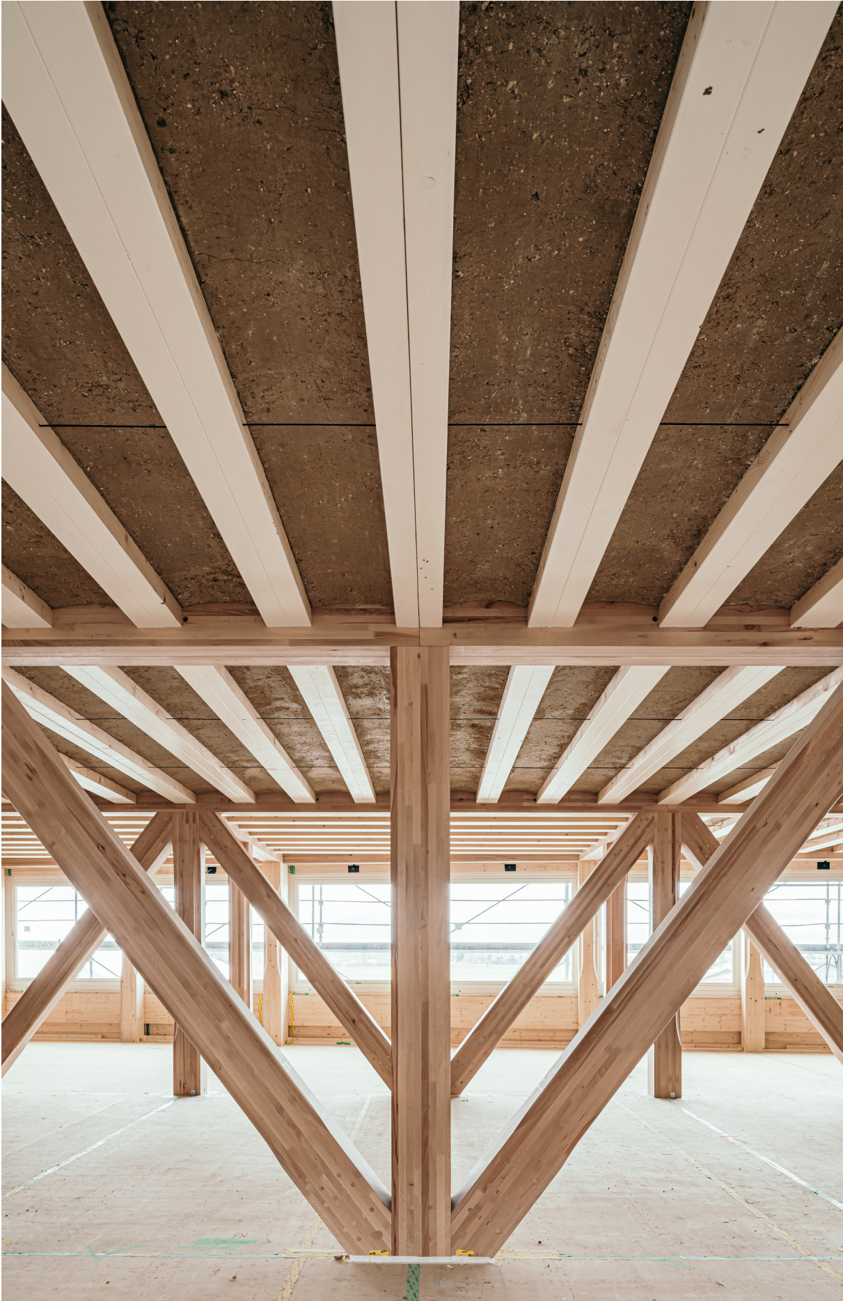
02 Hortus Basel, Innenansicht – Holz Lehm Decke
