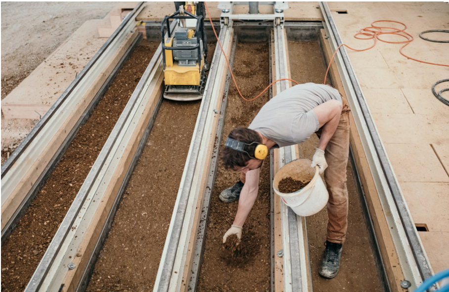
08 Füllen der Elemente im Feldfabrik – Hortus Basel
