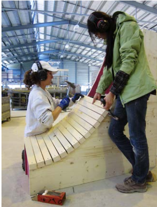
Gewölbeschalung bauen, Lehm stampfen, Ausschalen, Werkhalle
