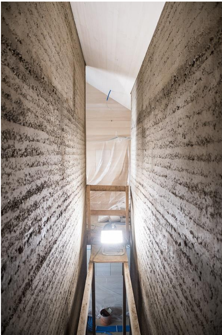
Stampflehm kern Treppenhaus
