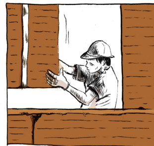
DIE VORGEFERTIGTEN MODULE WERDEN MIT LEHMMÖRTEL ZUSAMMENGEFÜGT.
