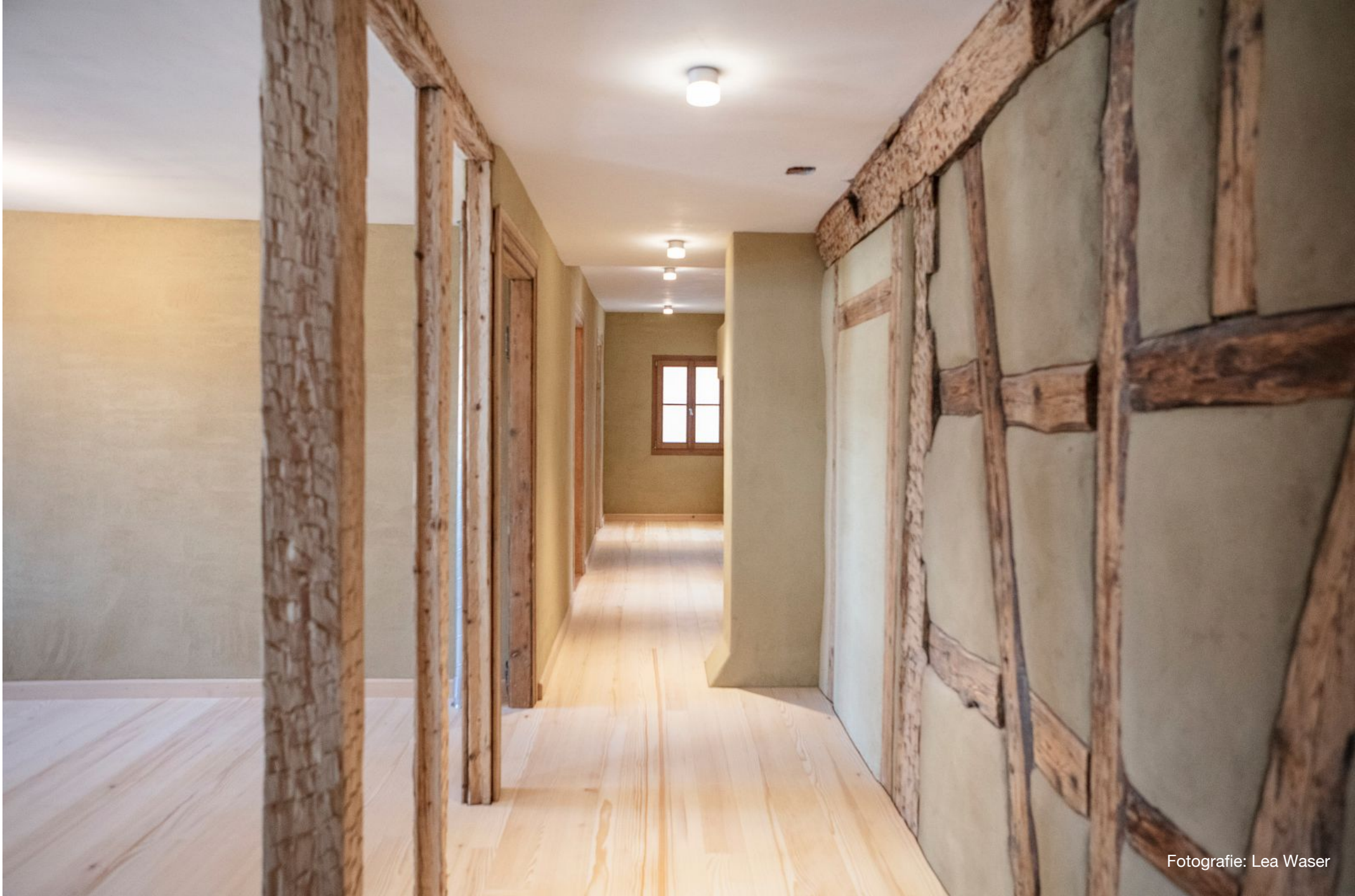
Umbau Bauernhaus mit Scheune: arge lehmbaubüro & chloe architektur
